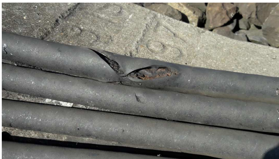
Obr. č. 7: Poškozené lano
